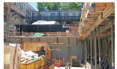
Rohbauarbeiten in vollem Gange
